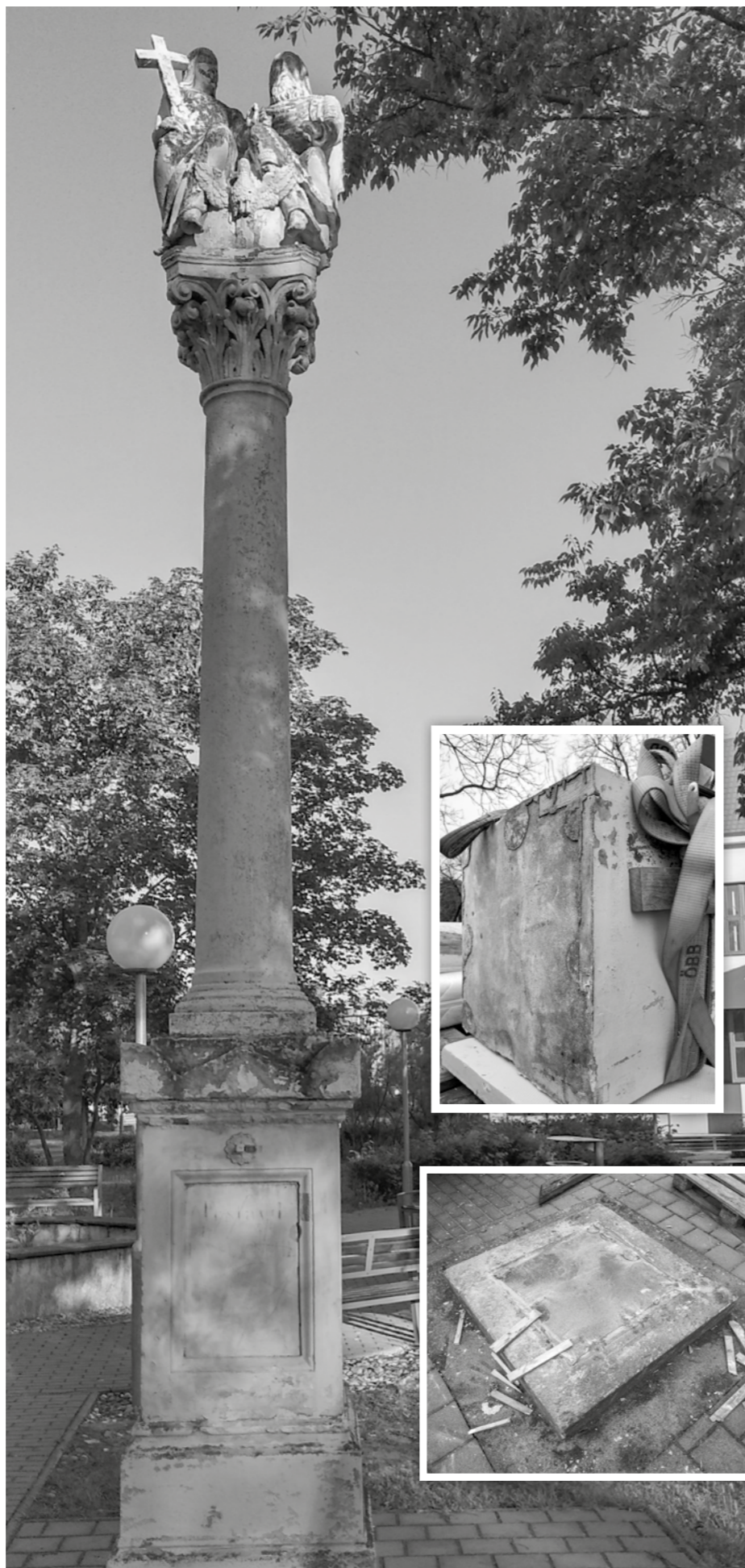
- Stĺp Svätej Trojice a jeho stredový a spodný diel pred obnovou -
