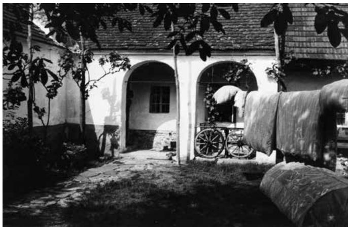
- Pohľad na bývalý dom Františka Ondrejku z dvora -
