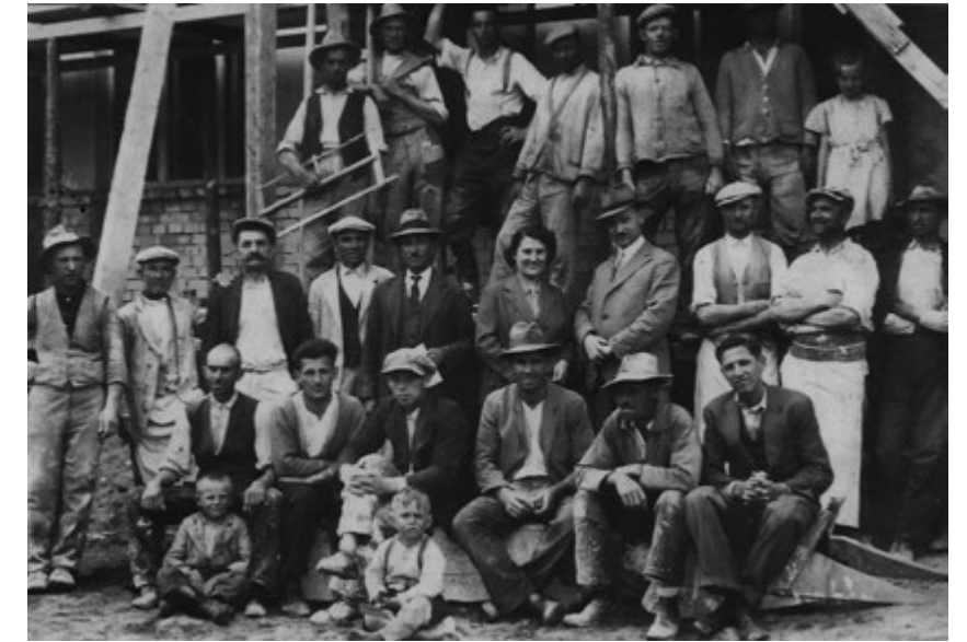
Stavba školy v roku 1934. Druhý zprava v strednom rade je murársky majster Jozef Hubek. Štvrtý zprava je staviteľ Martin Plačko, vedľa neho jeho manželka Etela, rod. Slobodová.
