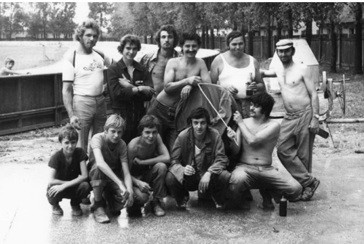
Kolektív brigádnikov AMK Zohor v 70-tych rokoch na budovaní areálu na miestnom štadióne ...
