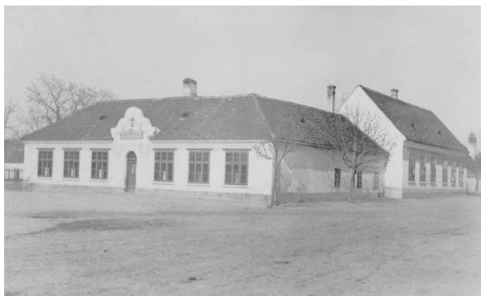
Budova školy r. 1908 - 1934, predná, nižšia časť budovy bola postavená pred rokom 1865
