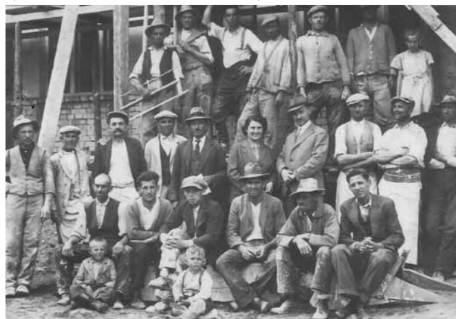
Stavba školy (terajšieho Obecného úradu) v Zohore v roku 1934. Druhý sprava v strednom rade je murársky majster Jozef Hubek
