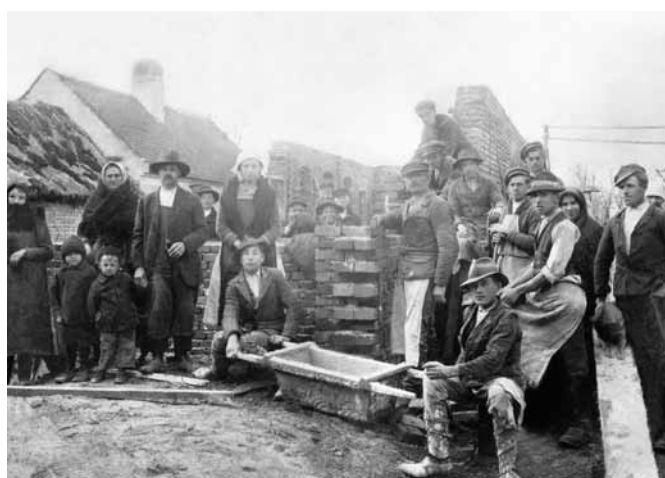
Murársky majster Andrej Pavlásek (s olovnícou v ruke) pri stavbe rodinného domu v Zohore v roku 1922
