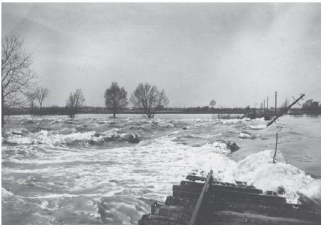
Pretrhnutá železničná trať
